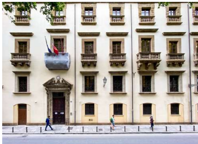
Fig. 6 - Il prospetto principale sulla via V. Emanuele (F.R. 2024).
