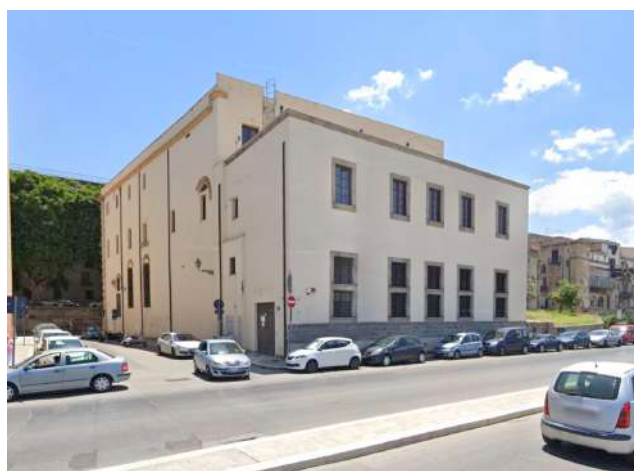
Fig. 8 - Vista dell'edificio dalla via della Cala (Google 2023).
